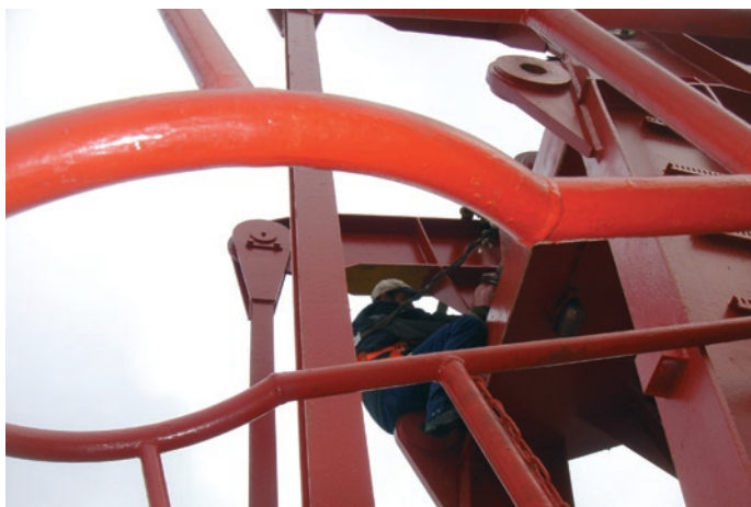
Bild 2: Teils liefen die Montagearbeiten in Schwindel erregender Höhe ab
